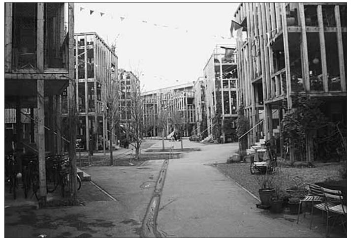
99 Genossenschaftswohnungen an der Huberstrasse, 3008. Foto: ar
